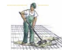
5. **Fläche sauber abkehren und mit einer geeigneten Rüttelplatte mehrmals längs- und quer abrütteln.** Immer an einer Außenseite der Fläche und am tiefsten Punkt beginnen. Zum Schutz der Steinoberfläche vor Kratzspuren und Kantenabplatzungen einen Rüttler mit Kunststoff- oder Gummipolster verwenden. Nachmals mit Fugensand ein- und anschließend abkehren. **Die gepflasterte Fläche ist nach dem Rütteln sofort benutz- und befahrbar.**
