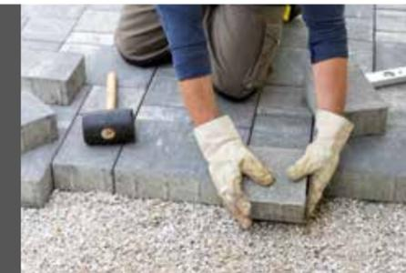
1. **Pflastersteindecken** sind einzufassen, um ein Verschieben des Betonsteinpflasters zu verhindern. **Randeinfassungen** sind gemäß den Richtlinien und Vorschriften für den Straßenbau (RVS) auszubilden. **Betonrandsteine** in Pflasterdrainbeton versetzen und Rückenstütze ausbilden. Alternativ können Randeinfassungen auf eine erhärtete Betonunterlage im Drainmörtelbett verlegt werden. In Bereichen ohne Belastung können auch nagelbare Kunststoff- oder Metallrandschienen verwendet werden.
