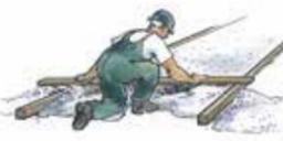
3. **Für ein ausgewogenes Farbbild:** Verlegung der Steine aus mehreren Paletten gleichzeitig und am tiefsten Punkt der Fläche im rechten Winkel beginnen. Für die **fluchtgerechte Verlegung** eine Schnur spannen und darauf achten, dass Sie das abgezogene Splittbett nicht mehr betreten. Achten Sie auch auf eine **Mindestfugenbreite von 5 - 8 mm** und kontrollieren Sie mittels Schnur/Latte ob die Fugenlinien nachzurichten sind.
